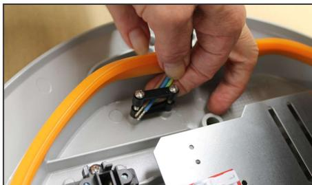
8. Das Kabel an die Klemme anschließen. Den Kabelhalter befestigen. Die Leuchte schließen.
